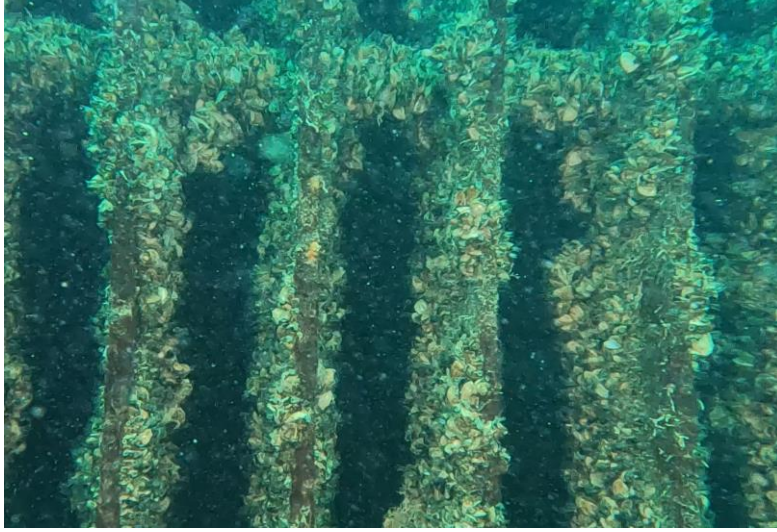
Şekil 7. Atatürk Barajı Izgara yapısı bölgelerde zebra midye ( D. polymorpha ) kolonisi (Orijinal, 2024)
