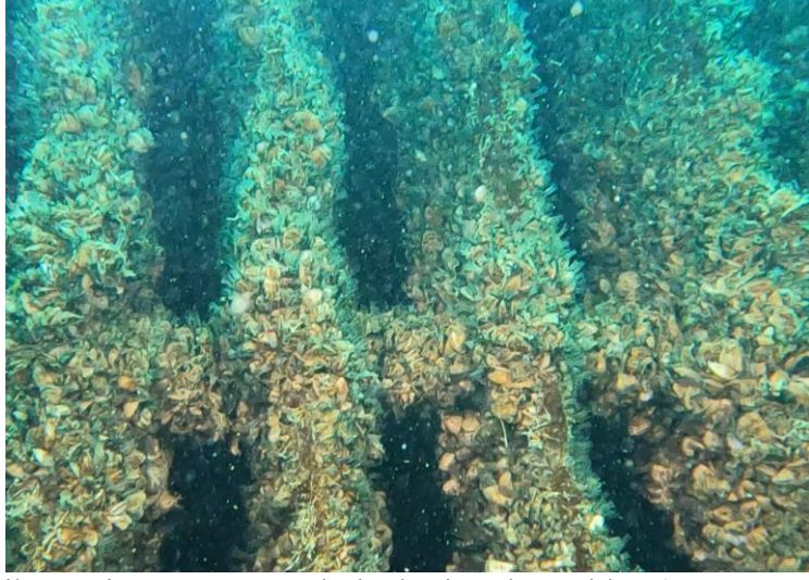
Şekil 5. Birecik Barajı Izgara yapısı bölgelerde zebra midye ( D. polymorpha ) kolonisi (Orijinal, 2024)
