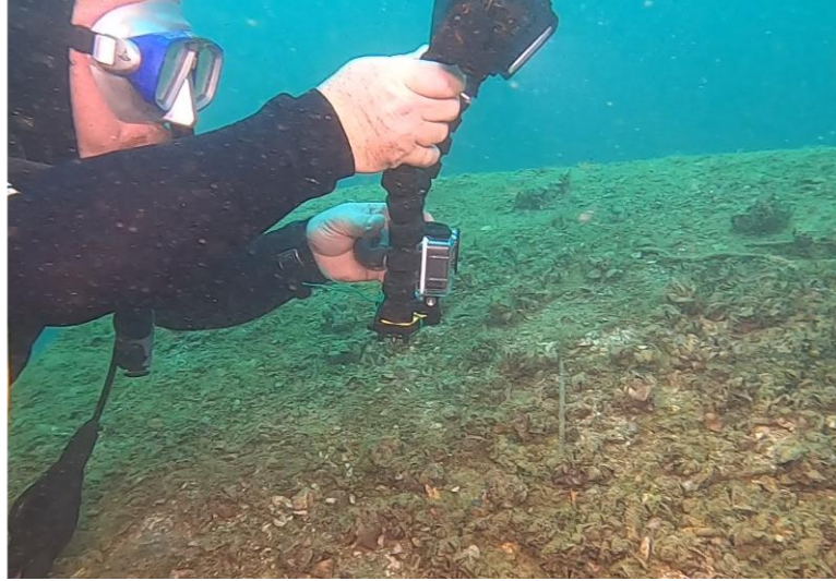
Şekil 6. Birecik Barajı Betonarne bölgelerde zebra midye ( D. polymorpha ) kolonisi (Orijinal, 2024)
